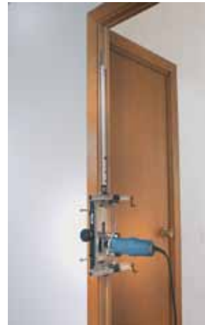
Фрезерование под 3 петли.
