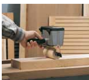
Нанесение винилового водорастворимого клея.
