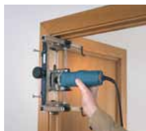
Фрезерование в верхней части рамы.
