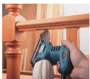
Шлифование трудно-доступных поверхностей.
